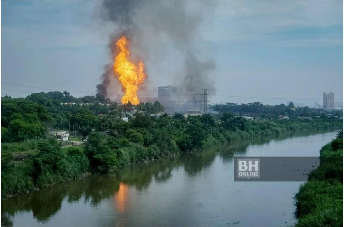
Kebakaran membabitkan saluran paip gas sepanjang 500 meter di stesen minyak di Jalan Putra Harmoni, Putra Heights. NSTP/ASYRAF HAMZAH
